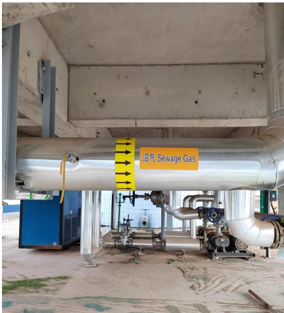
沼气脱硫系统沼气输送管道
