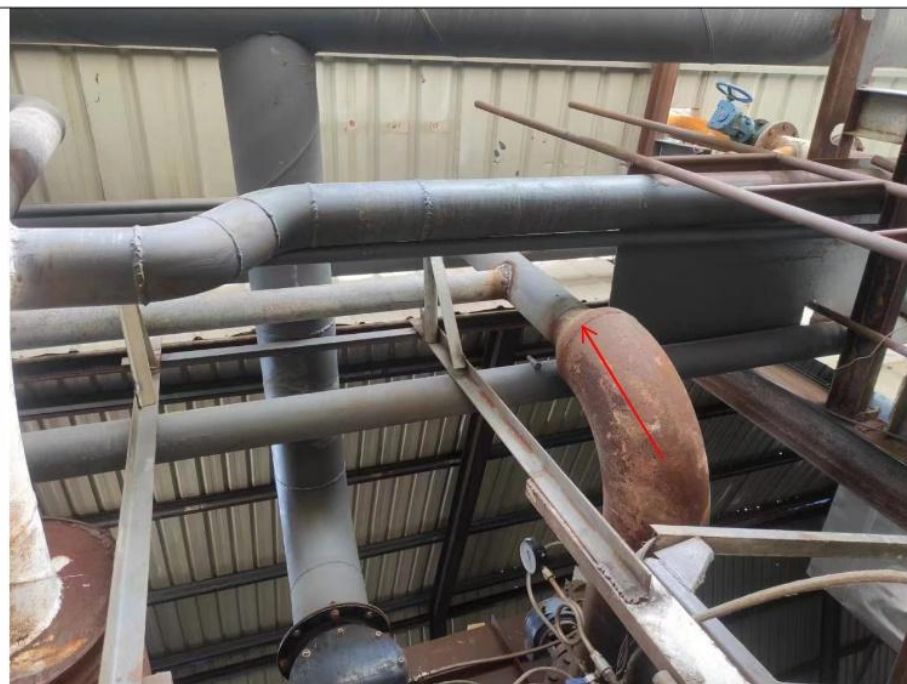
甲胺工艺废气、GBL 脱轻回收塔废气、中间储罐废气通过此管道进入导热油炉
