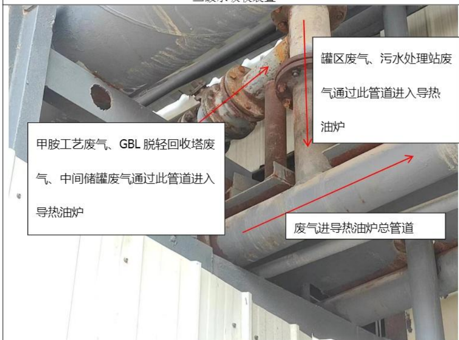
废气进导热油炉总管道
