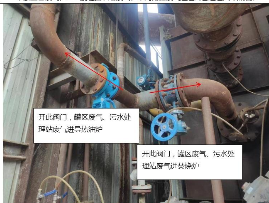
罐区废气、污水处理站废气
