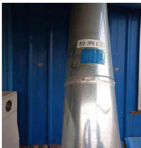
整改后检测口
