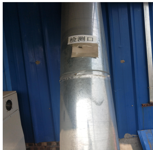
整改前检测口
