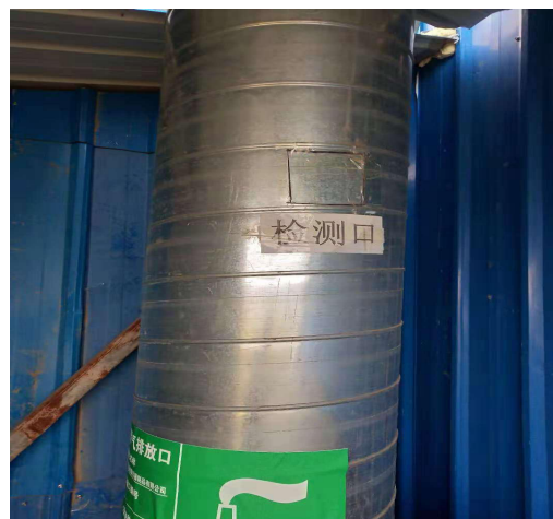
整改后检测口
