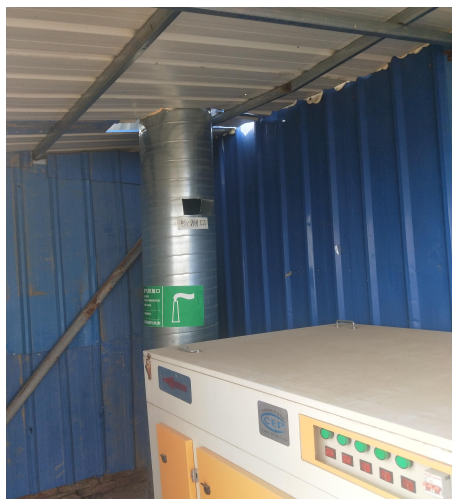
整改前检测口
